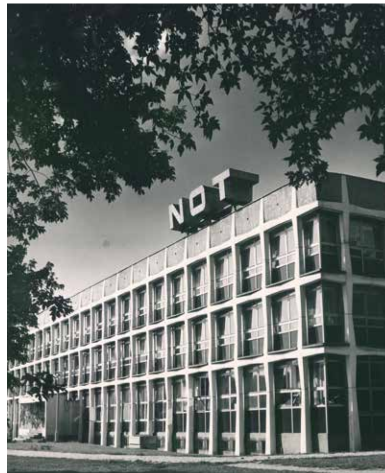
Budynek NOT ul. prof. Włodzimierza Krukowskiego, autorzy projektu architekt Tadeusz Derlatka i konstruktor J. Stępień, 1987 rok.
