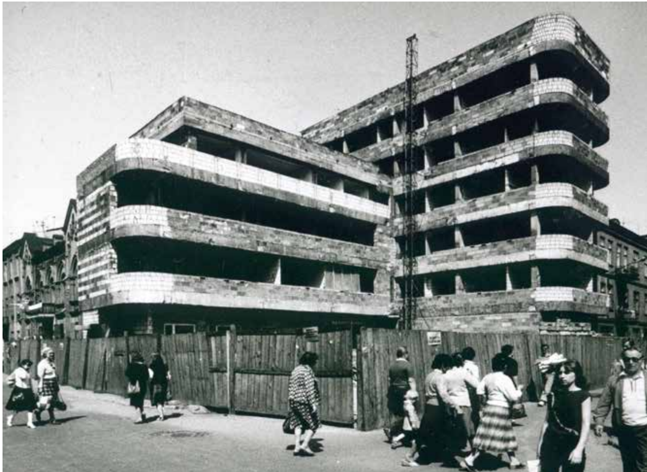
Budowa Domu Rzemiosła przy zbiegu ulic Jana Kilińskiego i Ferdynanda Focha według projektu Bogusława Bluma i Ryszarda Stępnia, 1986 rok. Fotografia Wojciecha Stana.
