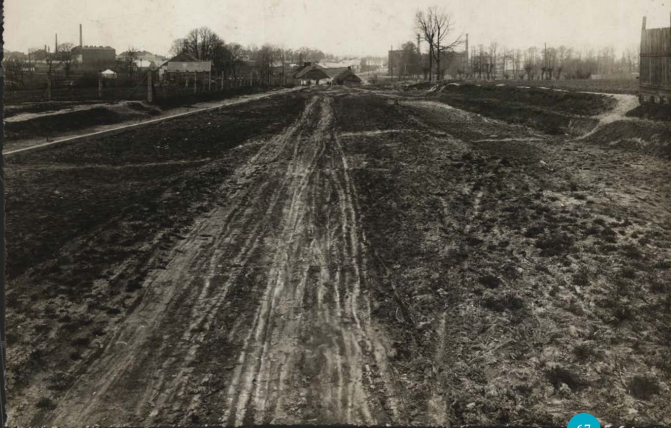
Radom 1929r. ul. Narwłowicza w czasie przebudowy.
