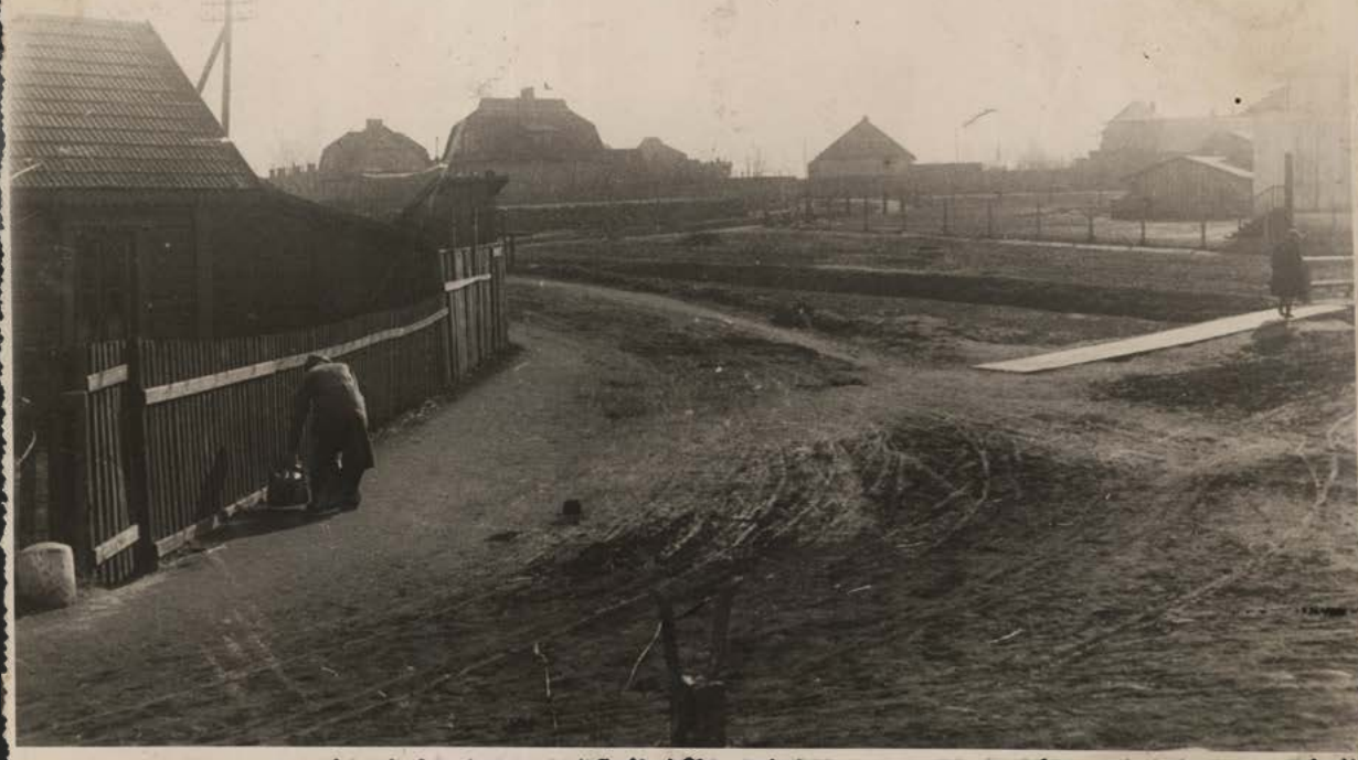
Radom 1936r. ul. Kolejowa od strony przejazdu kolejowego przed przystąpieniem do budowy.
