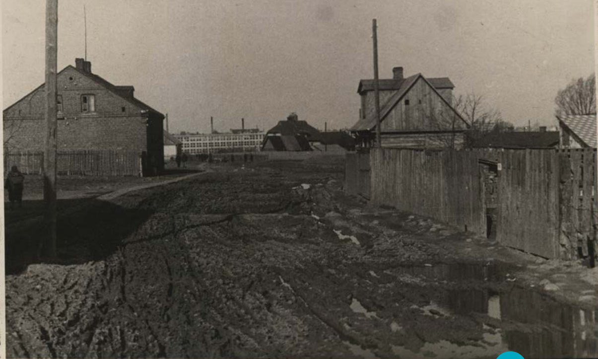
Radom 1936r. ul. Kolejowa przed budową w stanie gruntowym.
